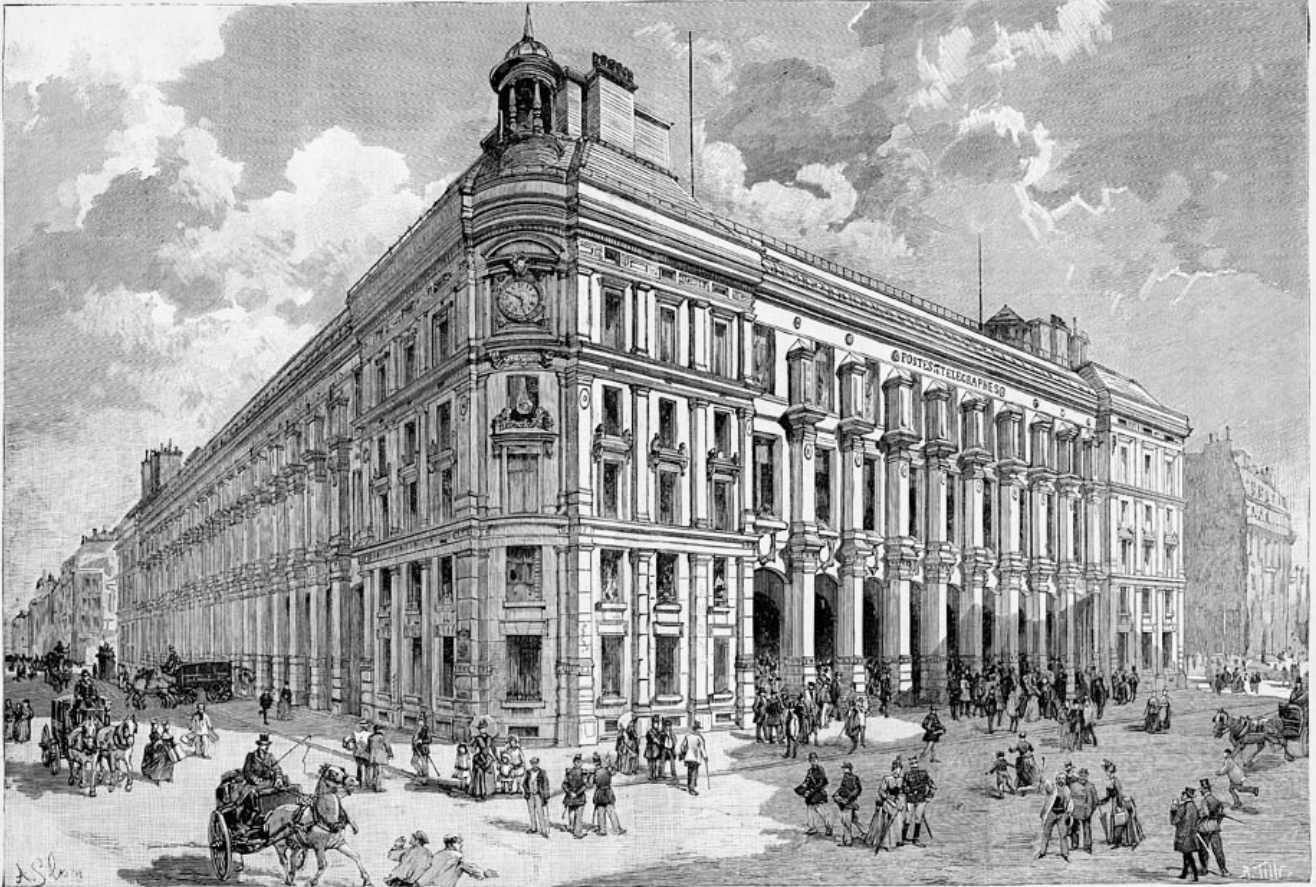
VUE GÉNÉRALE DE L'HOTEL DES POSTES
